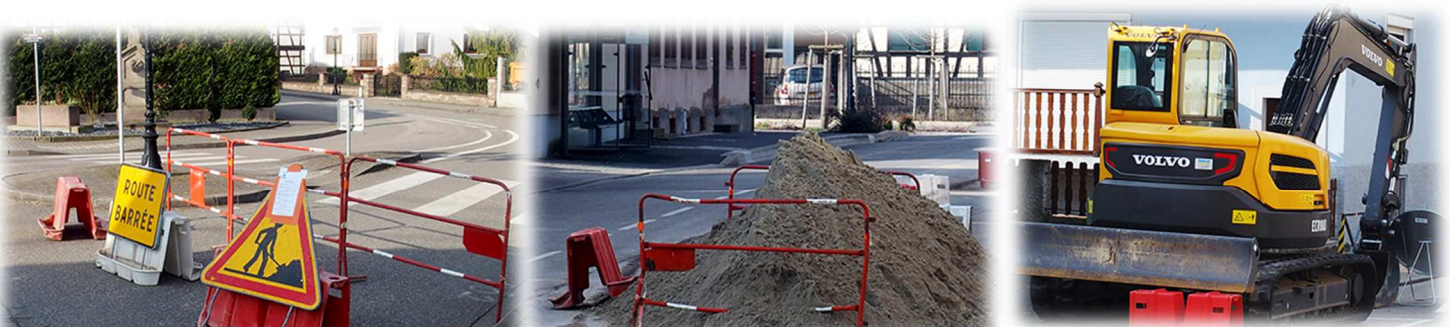
Mars : Les travaux de réfection de voirie ont débuté rue Jeanne d'Arc .
